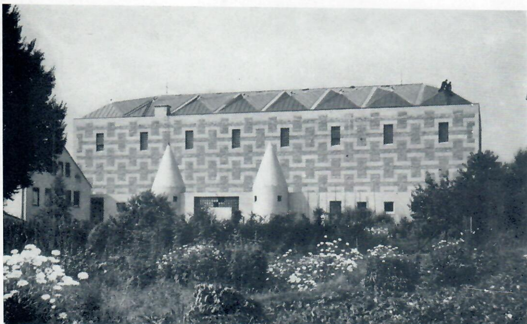
Der Neubau von Süden mit einem Kreuzmuster im Mauerwerk, Seitenschiff mit zwei Beichttürmen, dazwischen das Auferstehungsfenster (in Rot) um die Grablegungsgruppe, Sakristeien, darunter ein kleiner Pfarrsaal.
