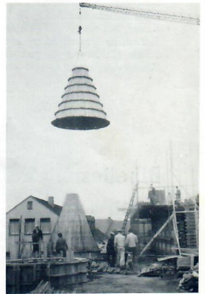
Form für den Guß eines Beichtturms wird eingefahren
