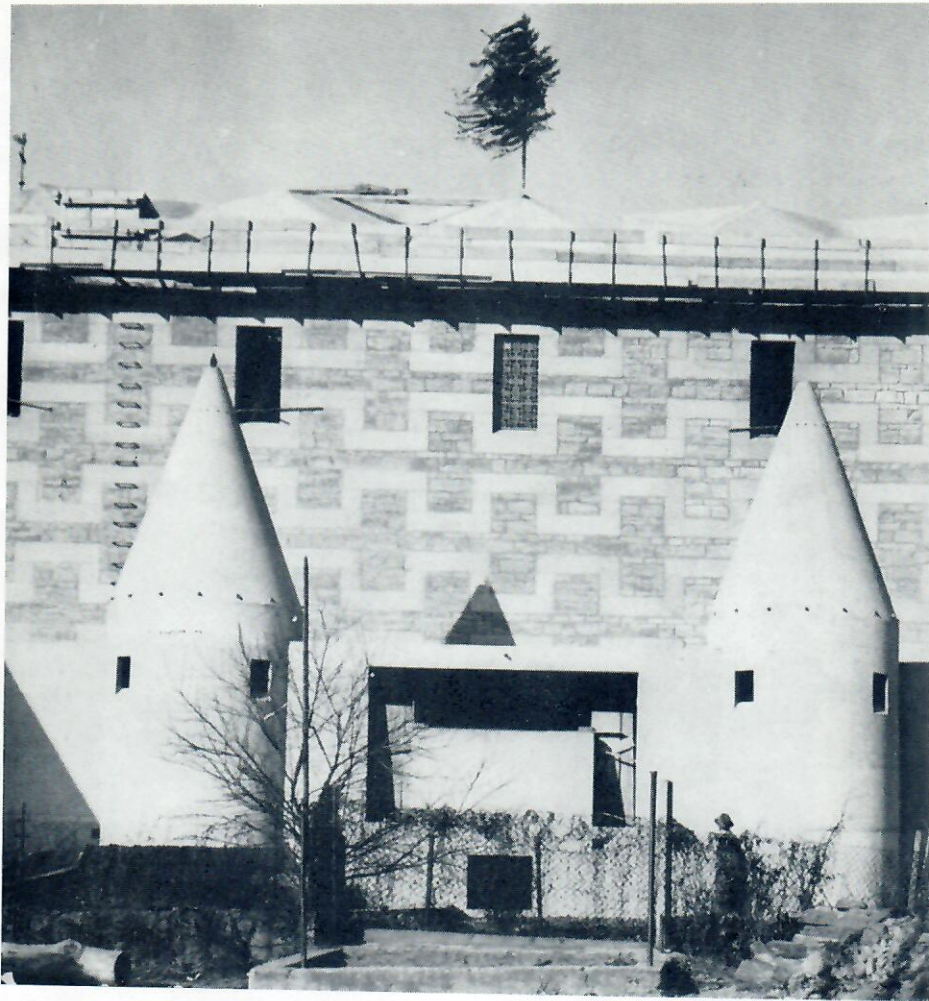
Richtstrauß über der fertig gegossenen Betondecke und Richtfest am 8. März 1961 Das erste der 16 Fenster im Bau
