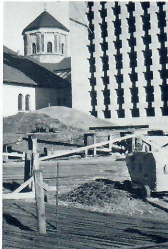
Die Eisenbiegerei arbeitete vor dem Pfarrhaus
