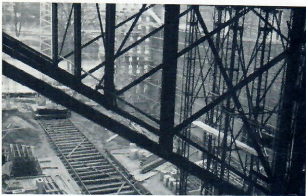
Innengerüst war von der Autobahn geliehen, sehr preiswerte Einrüstung möglich
