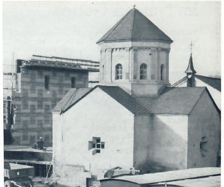
An der Alten Kapelle waren verschiedene Mauerproben aufgebaut
