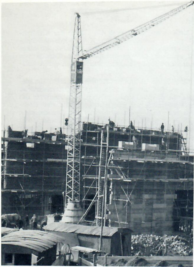
Der Kran bewegte sich auf einer Fahrbahn in-mitten der Kirche
